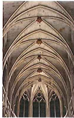
ภาพที่ 2.46 แสดงลักษณะโครงสร้างของหลังคาโค้งแหลม (point vault)
