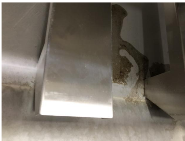
ภาพที่ 13 แสดงคราบสิ่งสกปรกบนพื้นผิว drain pan
