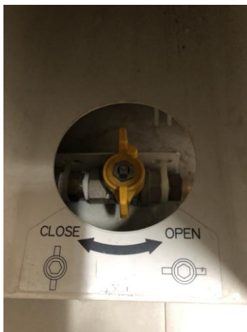
ภาพที่ 19 แสดงวาล์วเปิด-ปิด เพื่อถ่ายน้ำออกจากห้องหนึ่ง
