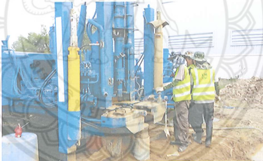
รูปที่ 6.8: การซ่อมบำรุงชุดชุดเจาะ
