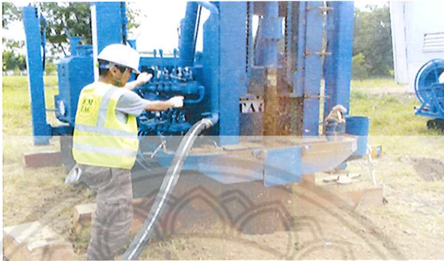
รูปที่ 5.8: แสดงการทำงานของหัวชุดเจาะขณะทำการขุด
