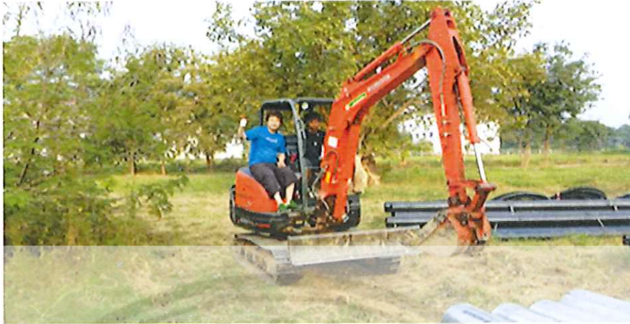
รูปที่ 5.5: การปรับพื้นที่ผิวเพื่อเตรียมพร้อมสำหรับการขุดเจาะ
