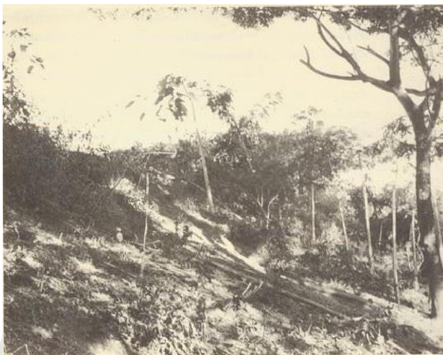
ภาพ 10 สภาพกำแพงดินเมืองน่าน บริเวณวัดพญาวัต
