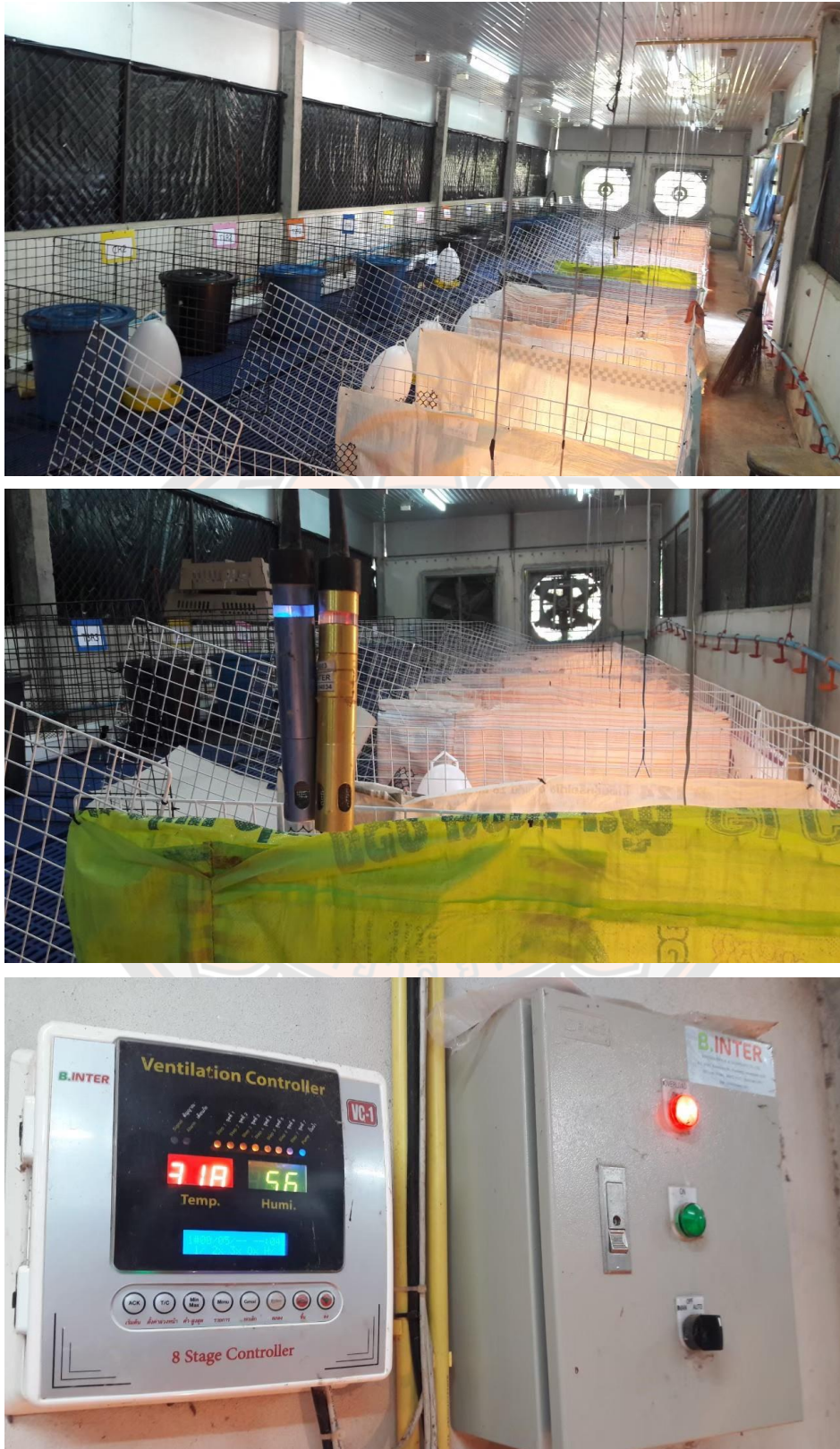
Figure 31 ฟันยาฆ่าเชื้อโรงเรือนเตรียมไฟก่อกูกเปิด (ภาพบน) เซ็นเซอร์วัดอุณหภูมิและความชื้น (ภาพกลาง) ตู้ควบคุมอุณหภูมิ (ภาพล่าง)
