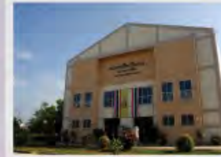
ก่อสร้างอาคารกีฬาบadminton พื้นที่ ตารางเมตร วงเงินค่าก่อสร้าง 16,750,000.00 บาท
