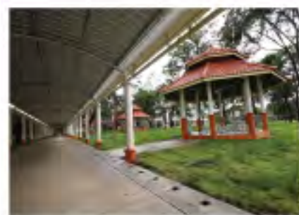
ก่อสร้างศาลาอ่านหนังสือ และปรับปรุงทางเดินเท้า ศาลพร้อมหลังคา พื้นที่ ตารางเมตร วงเงินค่าก่อสร้าง 4,970,000.00 บาท
