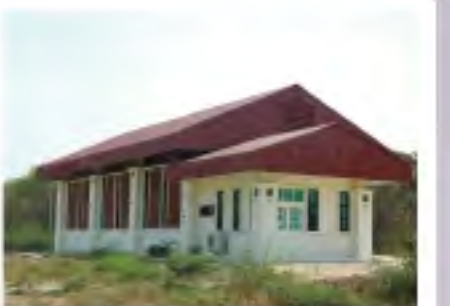
ก่อสร้างอาคารกายวิภาคศาสตร์ พื้นที่ ตารางเมตร วงเงินค่าก่อสร้าง 3,570,000.00 บาท
