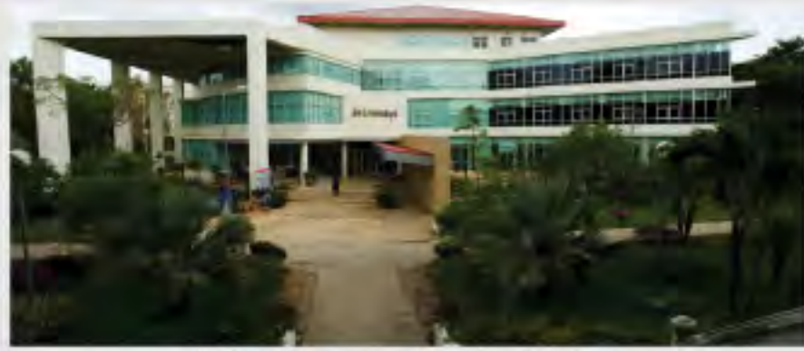
ก่อสร้างอาคารหอสมุดเอกประสงค์ มหาวิทยาลัยนครสวรรค์ พื้นที่ ตารางเมตร วงเงินค่าก่อสร้าง 124,000,000.00 บาท
