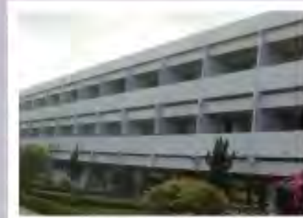
ปรับปรุงหอพักนิสิตชายเป็นที่พักบุคลากร ส่วนสนามบิน พื้นที่ ตารางเมตร วงเงินค่าก่อสร้าง 1,995,000.00 บาท
