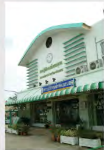
ก่อสร้างสถานีปฏิบัติการเภสัชกรรมชุมชน คณะเภสัชศาสตร์ พื้นที่ ตารางเมตร วงเงินค่าก่อสร้าง 4,600,000.00 บาท
