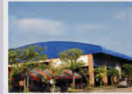
ก่อสร้างหลังคาลานกิจกรรมเอกประสงค์ (กองกิจการนิสิต) พื้นที่ ตารางเมตร วงเงินค่าก่อสร้าง 9,000,000.00 บาท
