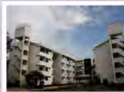
ปรับปรุงอาคารวิทยนิเทศ 3 เป็นห้องเรียน ปรับปรุงอาคารเรียนรวม (รวมมัธยมสาธิต) พื้นที่ ตารางเมตร วงเงินค่าก่อสร้าง 25,800,000.00 บาท
