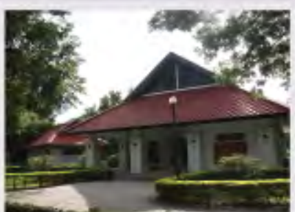
ก่อสร้างโรงจอดรถบริเวณกลุ่มอาคาร คณะวิศวกรรมศาสตร์ (ระยะที่ 2) พื้นที่ ตารางเมตร วงเงินค่าก่อสร้าง 349,245.00 บาท
