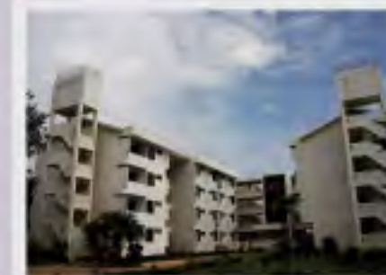
ปรับปรุงหอพัก มน. นิเวศ 7-8 พื้นที่ ตารางเมตร วงเงินค่าก่อสร้าง 2,089,000.00 บาท
