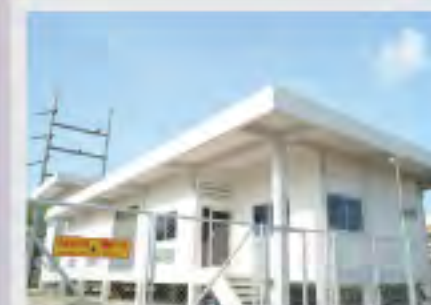
ก่อสร้างสถานีไฟฟ้าย่อย มหาวิทยาลัยนครสวรรค์ ขนาด 25,000 KVA วงเงินค่าก่อสร้าง 30,000,000.00 บาท
