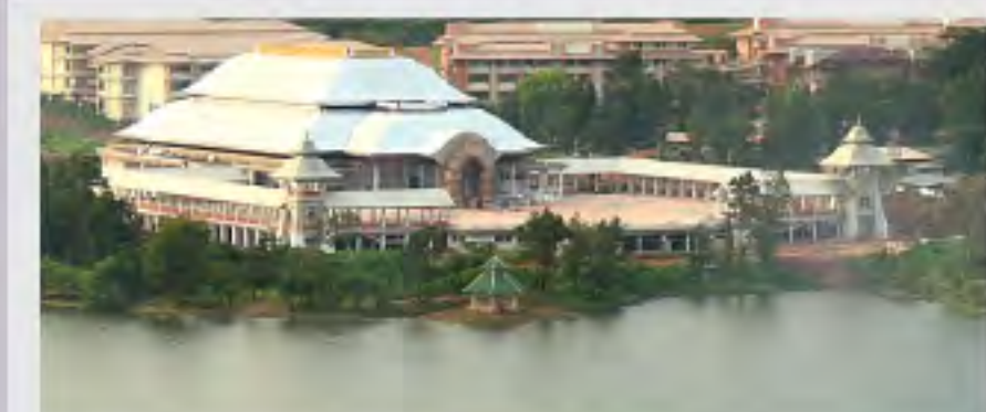
ก่อสร้างอาคารสถาบันศึกษาและสืบสานศิลปวัฒนธรรมสถาปัตยกรรมล้านนา(พะเยา) พื้นที่ ตารางเมตร วงเงินค่าก่อสร้าง 188,000,000.00 บาท
