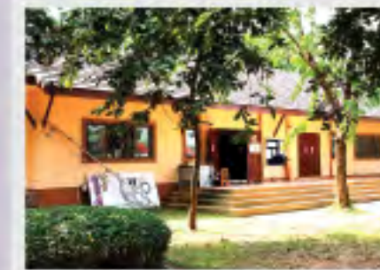
ก่อสร้างอาคารชมรมส่วนกลาง พื้นที่ ตารางเมตร วงเงินค่าก่อสร้าง 3,196,000.00 บาท
