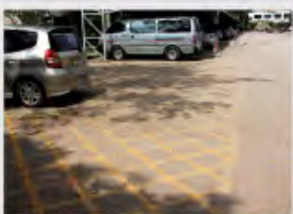
จ้างเหมาปรับปรุงพื้นลานจอดรถ คณะศึกษาศาสตร์ และบัณฑิตวิทยาลัย พื้นที่ ตารางเมตร วงเงินค่าก่อสร้าง 1,450,000.00 บาท
