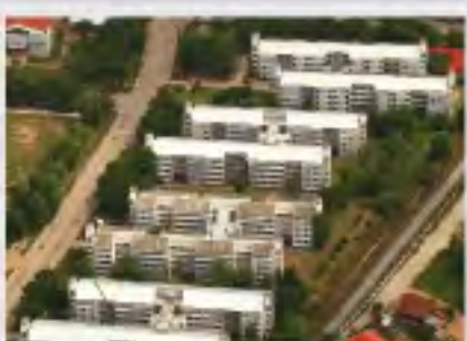
ปรับปรุงหอพักนิสิตหญิง 1-6 มนเรศวร พื้นที่ ตารางเมตร วงเงินค่าก่อสร้าง 1,895,000.00 บาท
