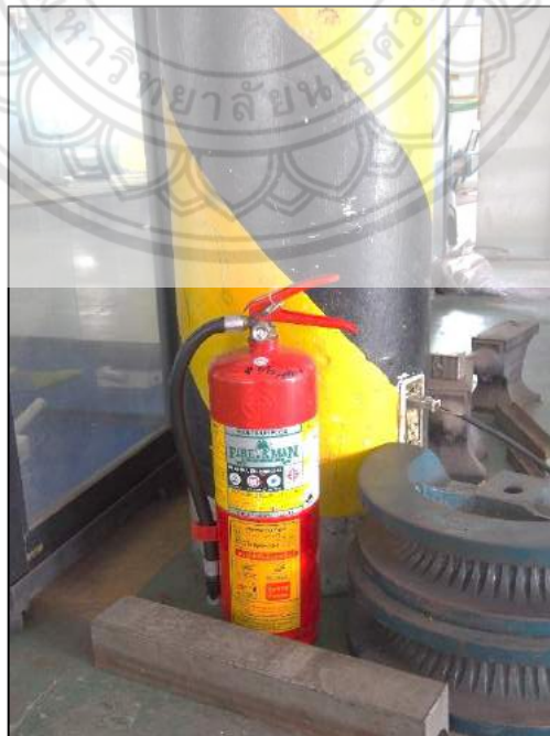
รูปที่ 4.7 ไม่มีการระบุตำแหน่งถังดับเพลิง
