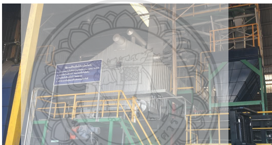
รูปที่ 3.4 หม้อน้ำที่ 1 ผลิตโดย GETABEC ขนาด 8 ton/hr
