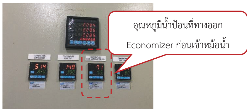
รูปที่ 4.9 เกจวัดอุณหภูมิน้ำป้อนก่อนเข้าสู่หม้อน้ำ
