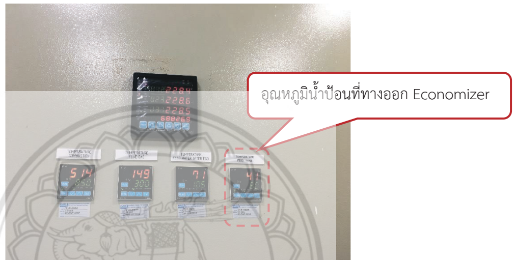
รูปที่ 3.24 หน้าจอสถงอุณหภูมิที่เกี่ยวข้องกับ Boiler
