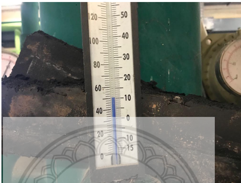
รูปที่ 4. 7 ตัวอย่างค่าอุณหภูมิน้ำเย็นจากเกจวัดอุณหภูมิของเครื่องทำน้ำเย็น
