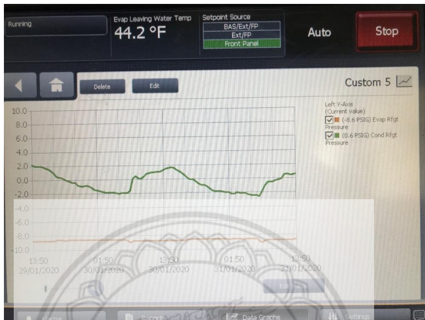
รูปที่ 4. 26 แสดงค่าความดันของสารทำความเย็นภายใน 2 วัน
