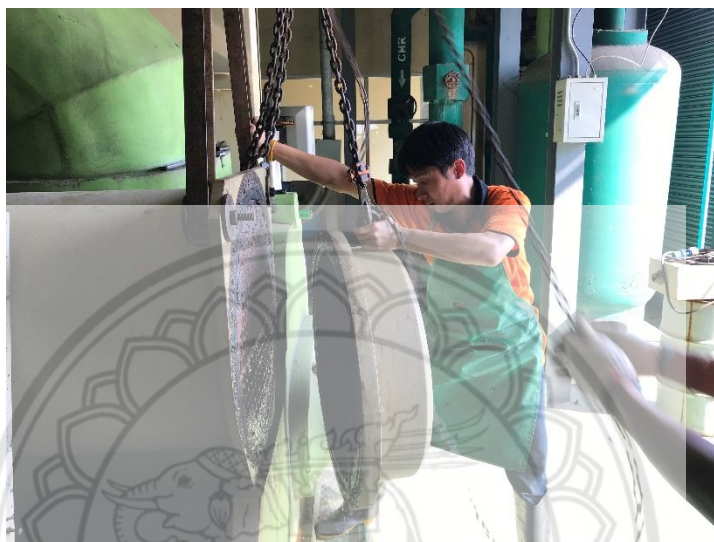
รูปที่ 4. 38 ทำการเปิดฝาครอบของ condenser
