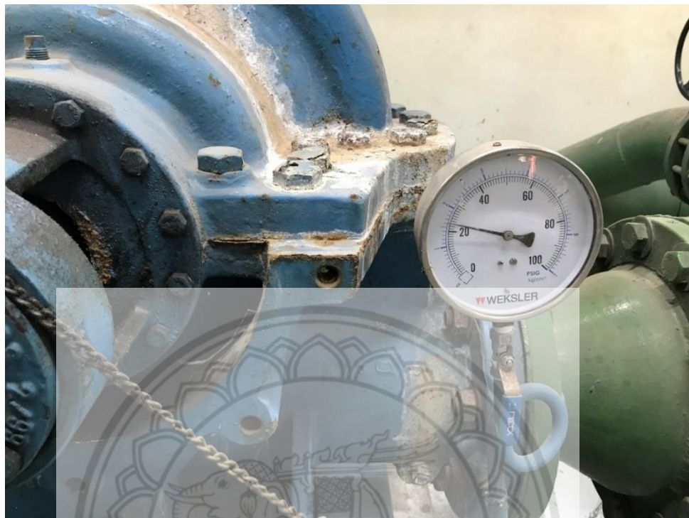
รูปที่ 4. 14 ตัวอย่างค่าความดันของน้ำขาออกของเครื่องสูบน้ำระบายความร้อนจากเกจวัดความดัน
