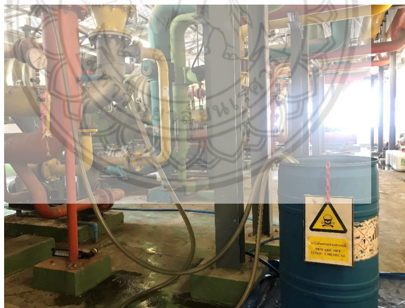
รูปที่ 4. 33 ทำการใส่สารเคมีอัดเข้าไปในท่อของ condenser
