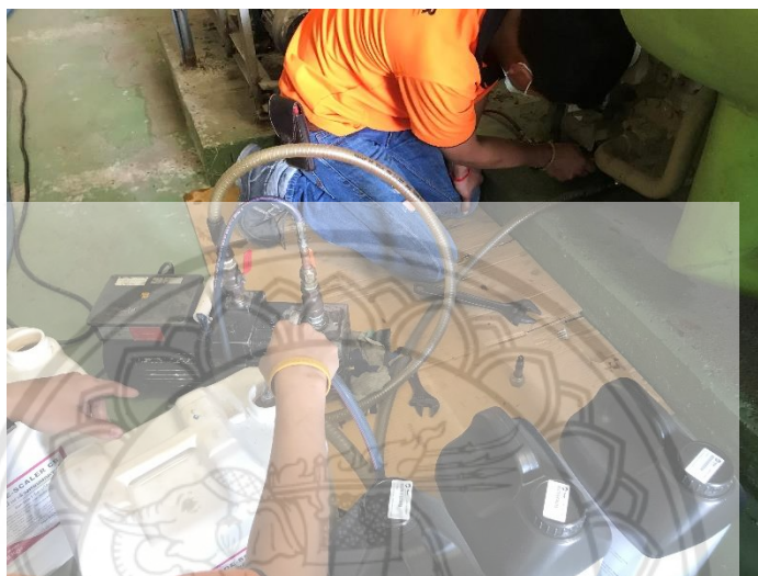
รูปที่ 4. 36 การถ่ายน้ำมันของ compressor ออกโดยใช้ pump
