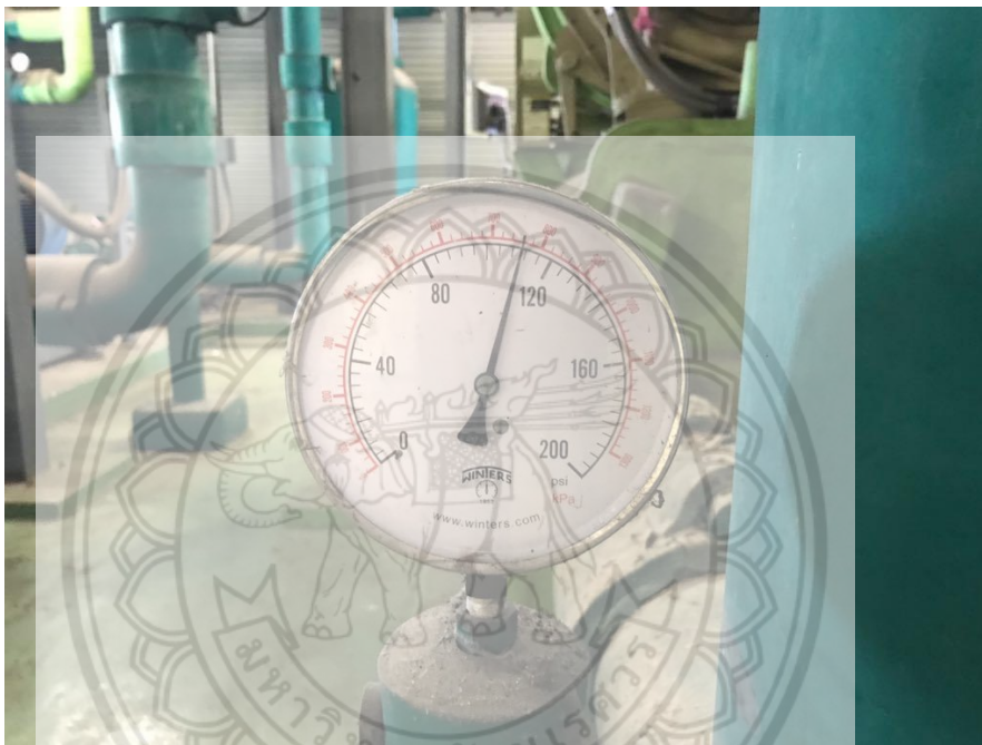
รูปที่ 4. 9 ตัวอย่างค่าความดันของน้ำเย็นจากเกจวัดความดัน
