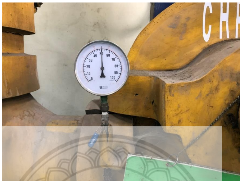
รูปที่ 4. 11 ตัวอย่างค่าความดันของน้ำขาเข้าของเครื่องสูบน้ำเย็นจากเกจวัดความดัน
