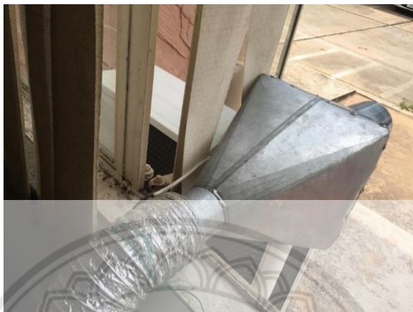
รูปที่ 3.6 ชุดระบายไอเสียร้อน
