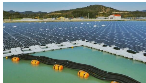
รูปที่ 2.8 การจัดเรียงสายไฟและอุปกรณ์
