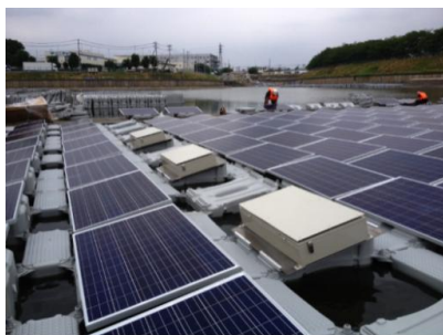
รูปที่ 2.8 การจัดเรียงสายไฟและอุปกรณ์
