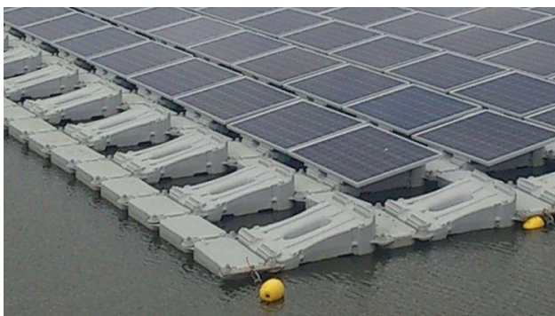
รูปที่ 2.4 ท่อนที่ตัวท่อนรวมกับแท่นรองรับเซลล์แสงอาทิตย์
