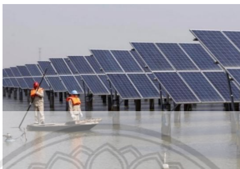
รูปที่ 2.7 การยึดแพลตฟอร์มระบบยึดถาวร
