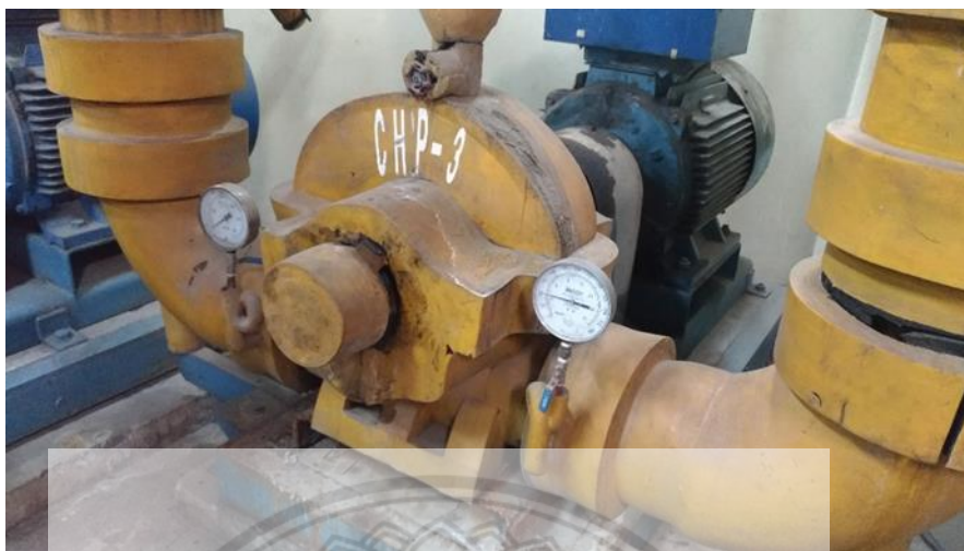
รูปที่ 4.8 คราบสนิมบริเวณ Chill Pump
