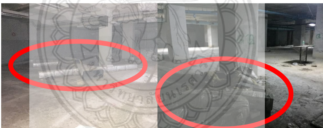
รูปที่ 4.5 ท่อลมที่ถูกถอดออกไว้ในชั้นใต้ดินของอาคารสิรินธร
