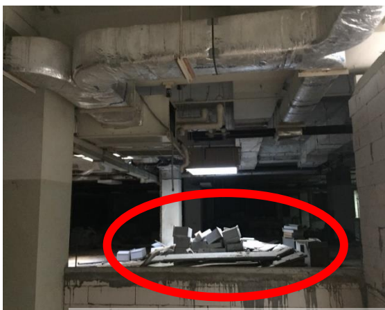
(ก) อุปกรณ์ที่ถูกรื้อถอน
