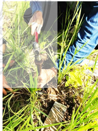
(ข) ใช้ค้อนทุบลงไปบนไม้ตักผู้
