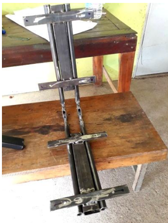
ก. เชื่อมโครงเหล็ก
