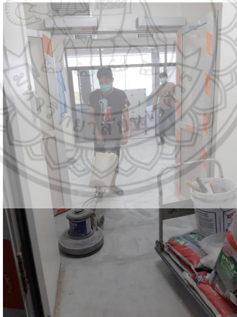
รูปที่ ง.12 การเตรียมพื้นห้องสำหรับปูกระเบื้องยาง
