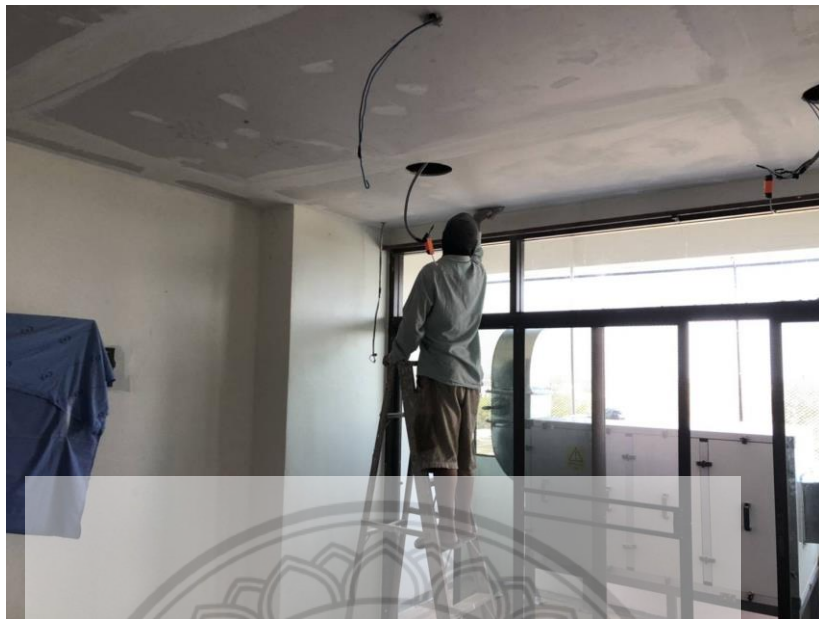
รูปที่ ง.13 การติดตั้งฝ้าเพดาน
