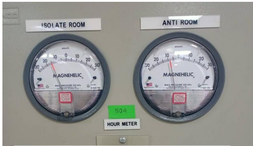
รูปที่ 4.61 หน้าจอแสดงผลของค่าความดันภายในห้องผู้ป่วยก่อนมีการปรับอัตราการระบายอากาศ
