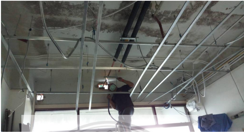
รูปที่ ง.11 การติดตั้งท่อส่งน้ำเย็นเข้าเครื่องส่งลมเย็น
