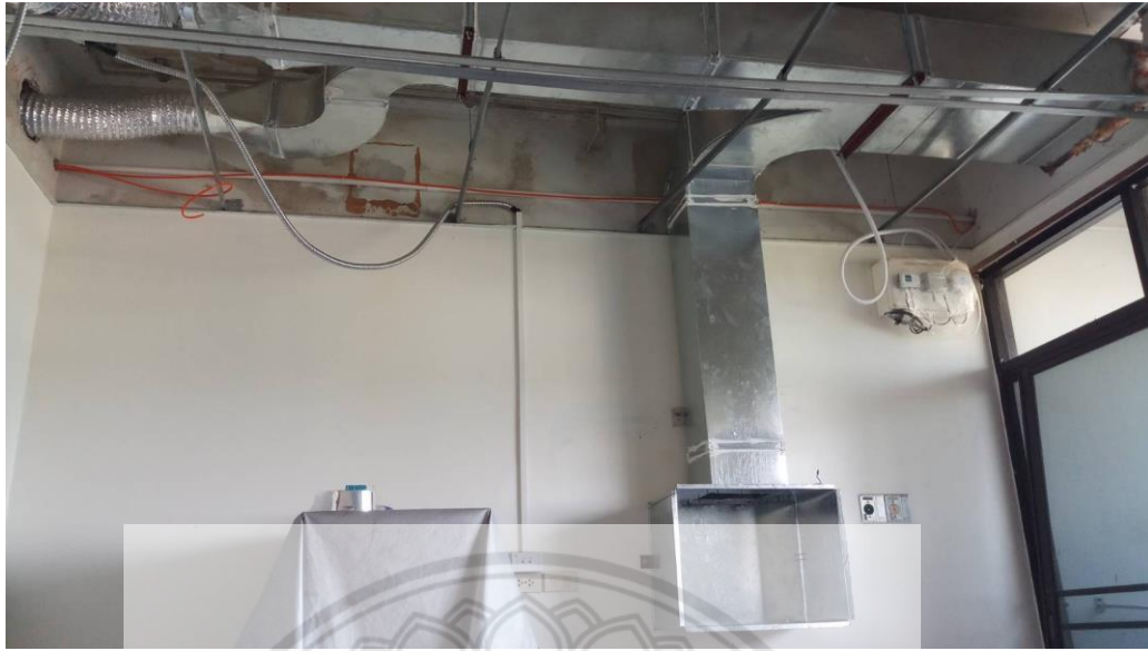
รูปที่ ง.9 ท่อลมระบบปรับอากาศและระบายอากาศ
