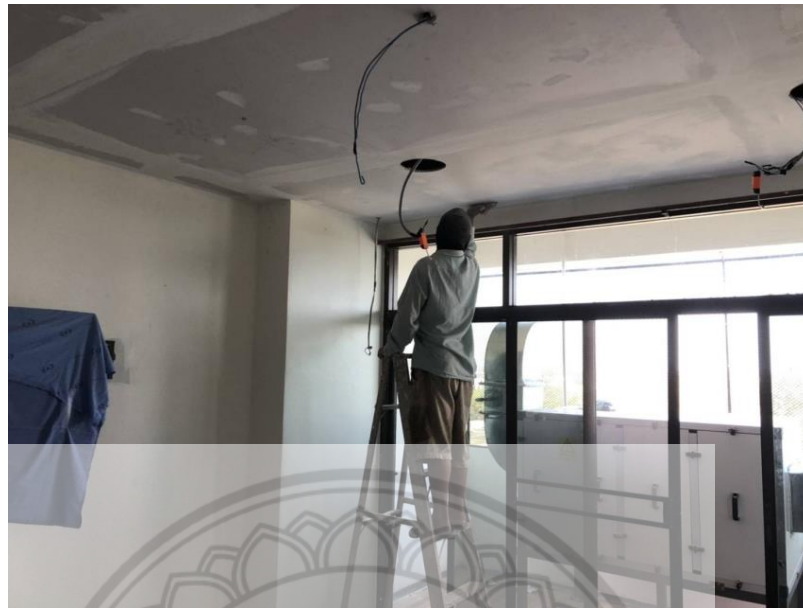
รูปที่ 4.27 การติดตั้งฝ้าเพดาน
