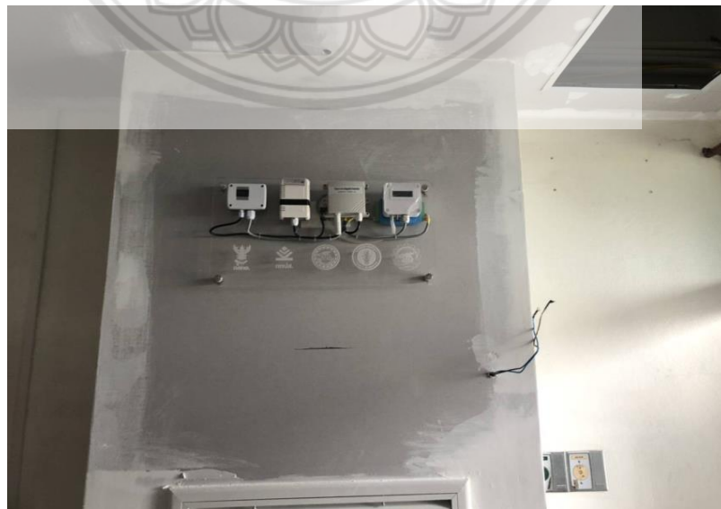
รูปที่ 4.28 ชุดเซนเซอร์ตรวจวัดคุณภาพอากาศ
