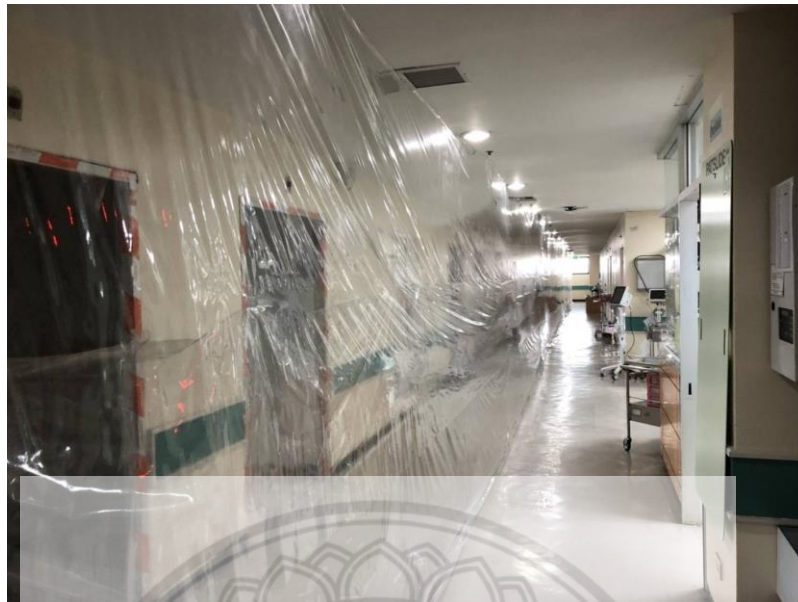
รูปที่ ง.5 การใช้พลาสติกใสในการปิดพื้นที่ทำงาน
