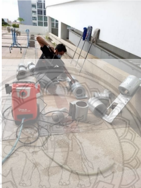
รูปที่ 4.22 การทำความสะอาดพัดลมของเครื่องส่งลมเย็น
