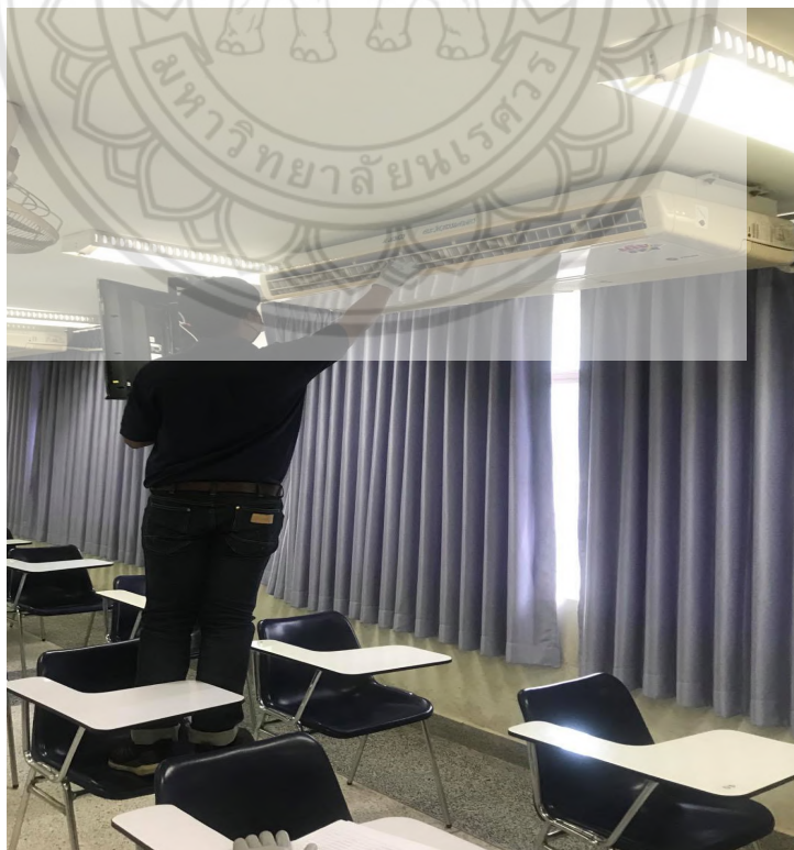
รูปที่ ค.4 การวัดกระแสไฟฟ้าของเครื่องปรับอากาศ
