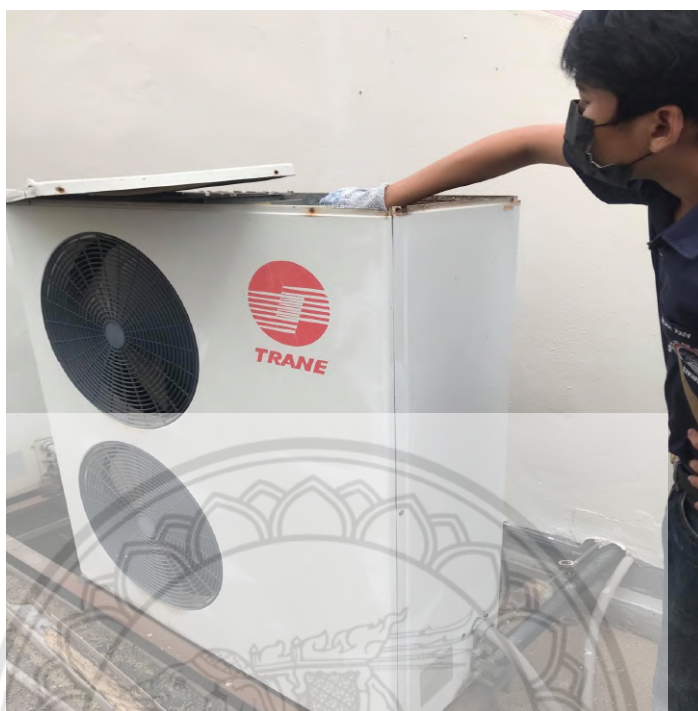
รูปที่ ค.4 การวัดกระแสไฟฟ้าของเครื่องปรับอากาศ
