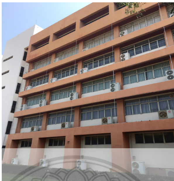
รูปภาพที่ 4.11 การติดตั้งคอมเพรสเซอร์ของอาคารเรียนรวมคณะวิศวกรรมศาสตร์
