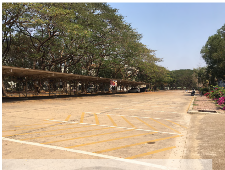
รูปภาพที่ 4.14 พื้นที่สำหรับจอดรถของอาคารเรียนรวมคณะวิศวกรรมศาสตร์
