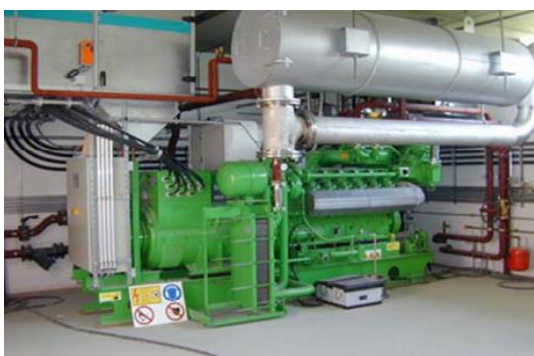
รูปที่ 2.10 เครื่องยนต์ผลิตไฟฟ้าจากก๊าซชีวภาพ
