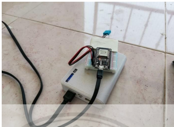
รูปที่ 3.8 การติดตั้งอุปกรณ์สำหรับเก็บค่าอุณหภูมิและความชื้นที่ภายนอกห้อง
