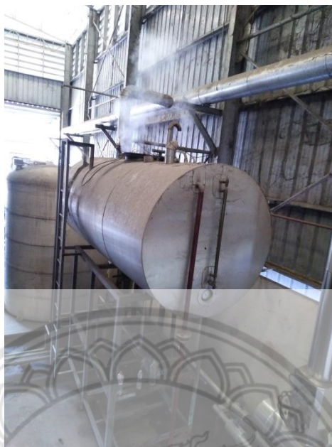
รูปที่ 3.14 ถังน้ำป้อนเข้าหม้อน้ำ
