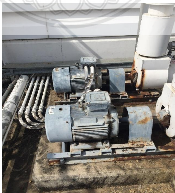
รูปที่ ข.2 ปั๊มน้ำเพื่อส่งน้ำหล่อเย็นไปที่ AHU
