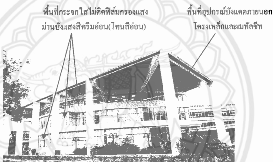
รูปที่ 3.3 แสดงลักษณะกรอบอาคารสำนักหอสมุดด้านทิศเหนือ
