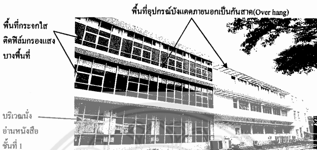
รูปที่ 3.4 แสดงลักษณะกรอบอาคารสำนักหอสมุดด้านทิศใต้
