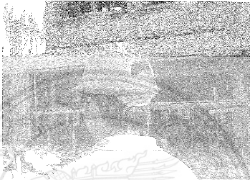
รูป 4.14 หมวกใบนี้คนงานที่เคยใส่ถูกท่อนเปิปเหล็กตกใส่ปรากฏว่าคนงานปลอดภัย
