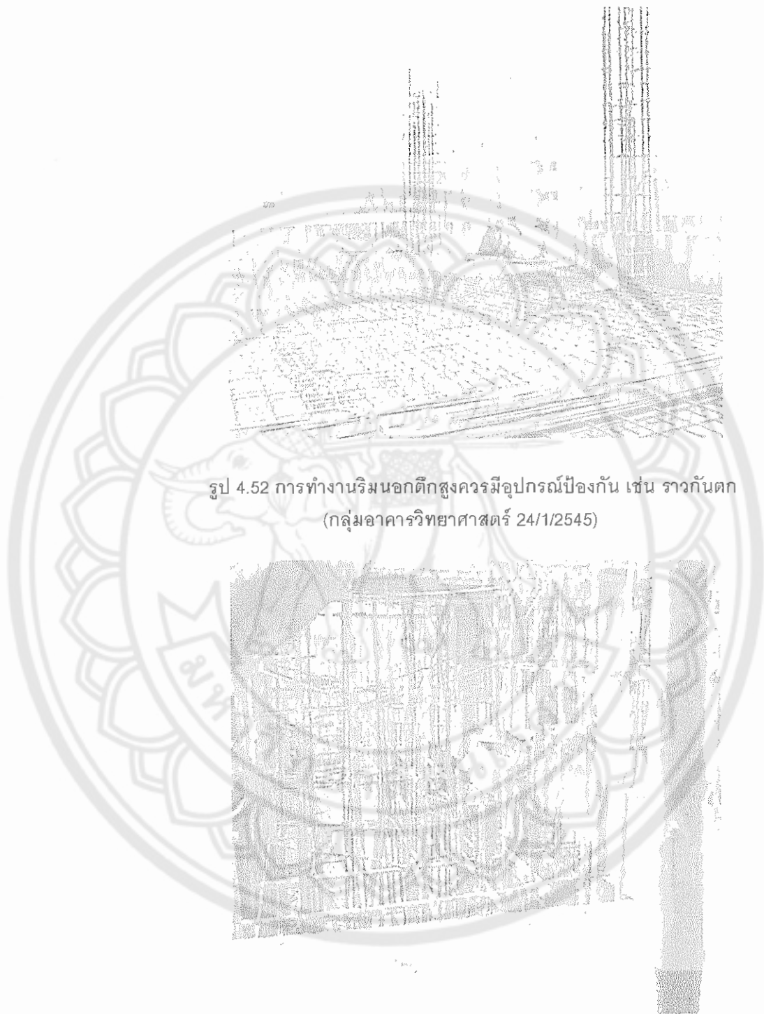
รูป 4.53 การขึ้นอยู่บนคานไม้แคบๆอาจพลาดตกลงมาได้ (กลุ่มอาคารวิทยาศาสตร์ 27/1/2545)
