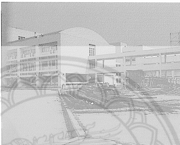
รูป 4.32 การวางกองเหล็กไว้เช่นนี้อาจเกิดอันตรายต่อผู้อื่นได้ (กลุ่มอาคารวิทยาศาสตร์ 12/1/2545)
