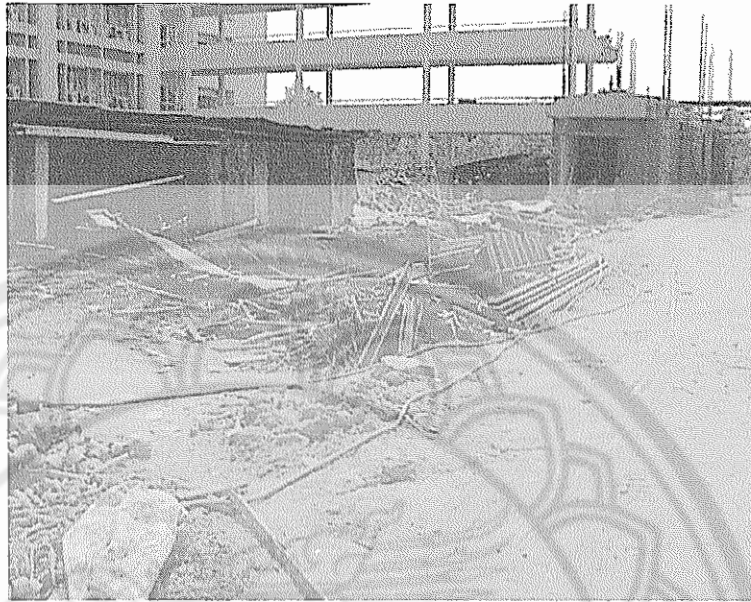
รูป 4.36 การกองวัสดุเหลือใช้หรือยังไม่ใช้ไว้ใกล้หลุมลึกเป็นอันตรายมาก (กลุ่มอาคารวิทยาศาสตร์ 12/1/2545)
