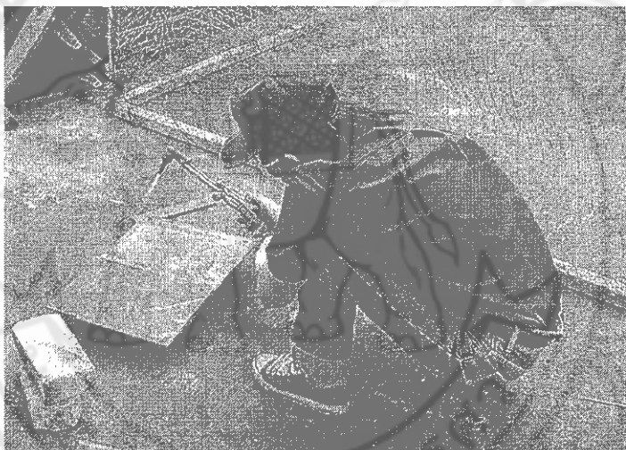
รูปที่ 3.17 การตัดด้วยแก๊ส
