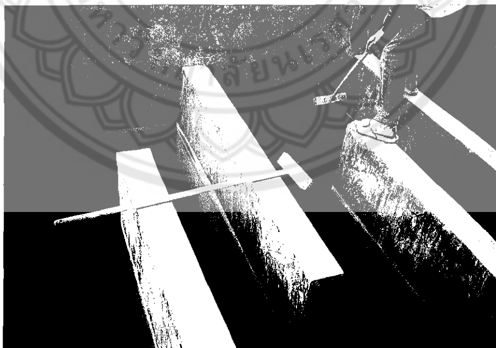
ภาพที่ 48 การทำความสะอาด Parshall Flume และ Flocculation Tank
