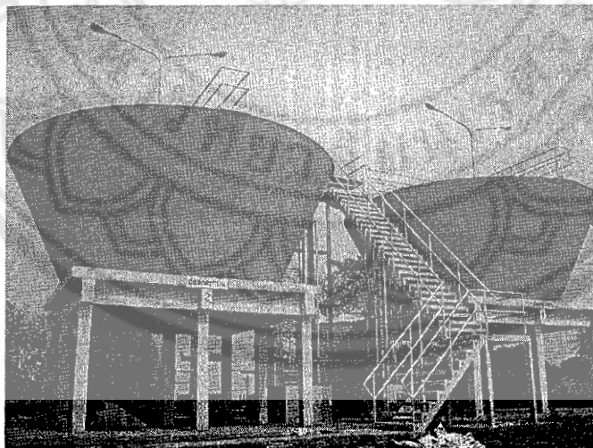
รูปที่ ข.2 ภาพแสดงถังกวนผสมและตกตะกอน
