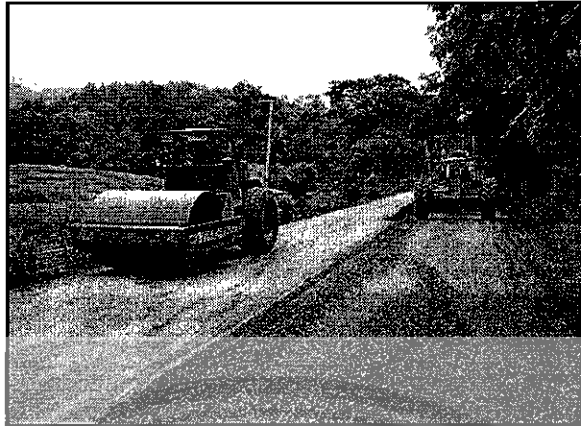
รูปที่ 2-17 การบดทับ (Compaction)
