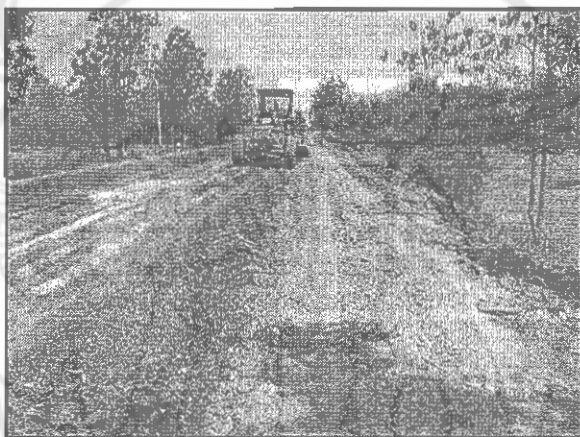
รูปที่ 2-16 การ Scarification พื้นทางเดิม
