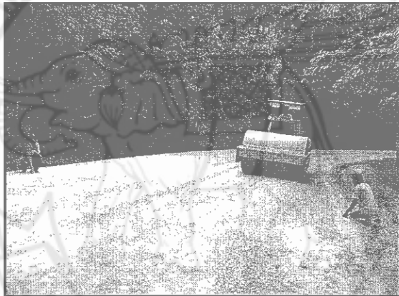
รูปที่ 2-20 การบดอัดพื้นทางใหม่
