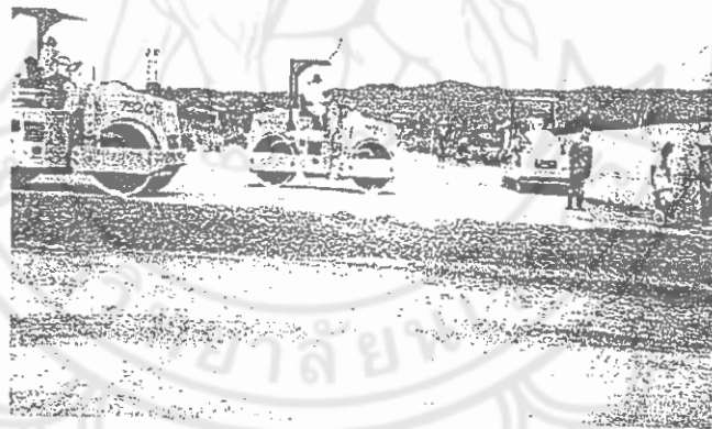
รูปที่ 2.24 การบดอัดคอนกรีต
