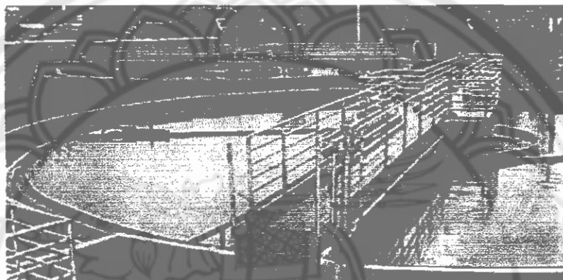
รูปที่ 2.4 ถังตกตะกอนแบบวงกลม (ที่มา : สมาคมสิ่งแวดล้อมแห่งประเทศไทย ,2545)
