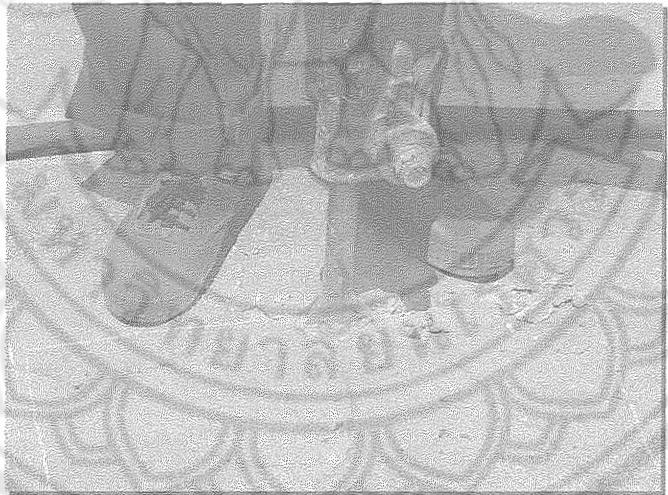
รูปที่ ข.2 การวางแนวเพื่อเจาะถนนสำหรับเป็นตัวอย่าง
