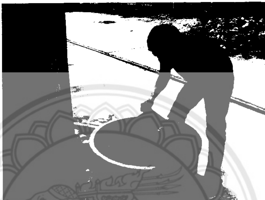
รูปที่ 3.12 การเตรียมการหมักดินเพื่อทำอิฐดินดิบผสมหญ้าแฝก
