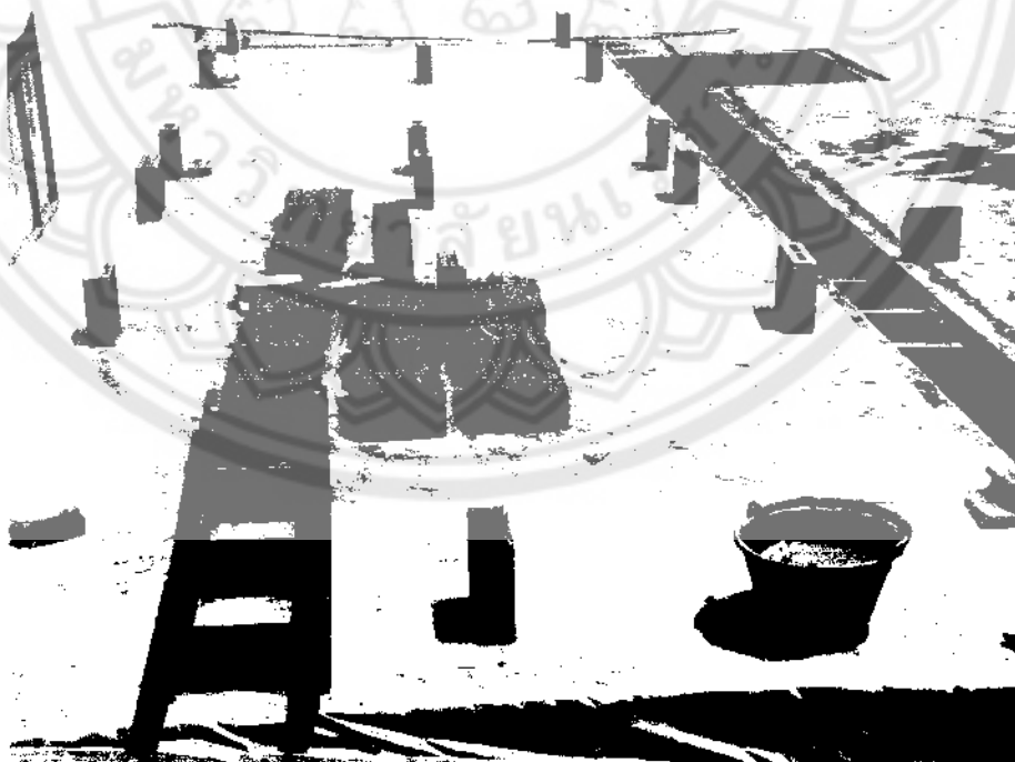
รูปที่ 3.19 การเตรียมการตากอิฐดินดิบ
