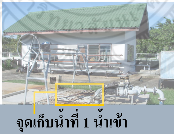
รูปที่ 3.1 จุดเก็บน้ำที่ 1 บ่อสูบน้ำเสีย
