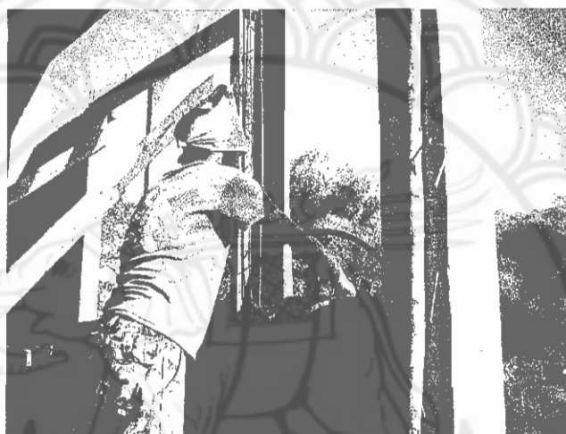
รูปที่ 47 การก่อผนัง ผู้ปฏิบัติงานไม่สวมถุงมือยาง
