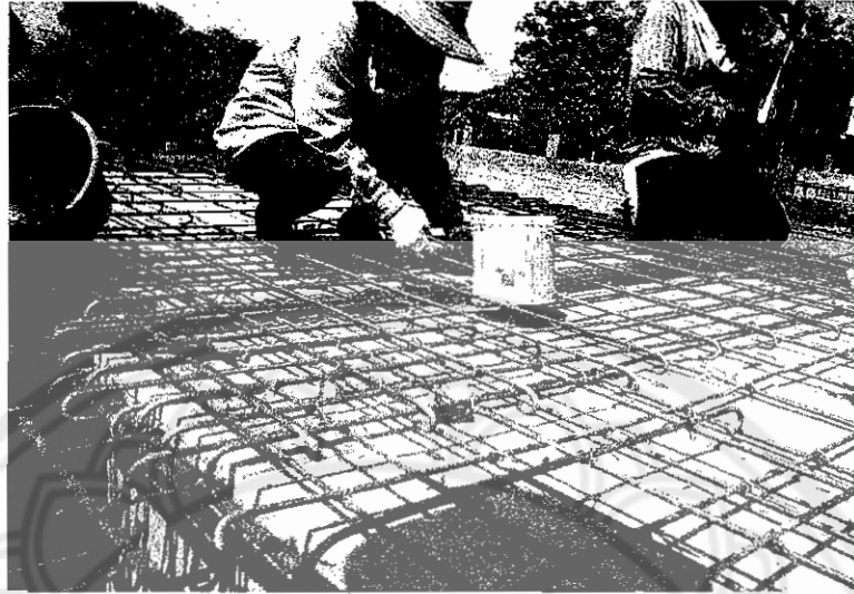
รูปที่ 34 การผูกเหล็ก
