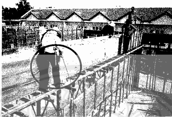
รูปที่ 30 ผู้แกะแบบคานไม่สวมเข็มขัดนิรภัยมีโอกาสเสี่ยงกับอันตรายได้มาก
