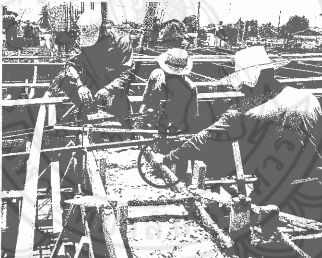
รูปที่ 32 ผู้ปฏิบัติงานมีโอกาสเสี่ยงที่จะสัมผัสกับน้ำปูนเป็นอันตรายได้
