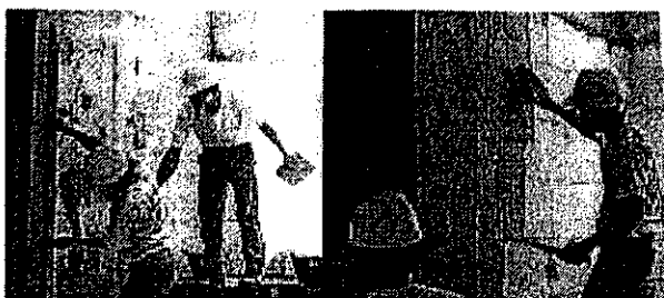
รูปที่ 2.38 แสดงการฉาบปูนซึ่งมักเกิดปัญหาแตกร้าวบ่อยครั้งหลังปูนแห้ง หากช่างไม่มีความชำนาญ
