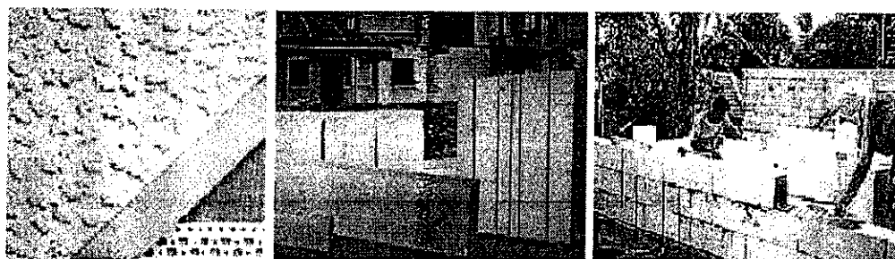
รูปที่ 2.37 แสดงลักษณะทั่วไปของคอนกรีตมวลเบาและการใช้งาน
