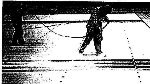
รูปที่ 2.53 แสดงบริเวณผิวหลังคาขณะที่กำลังทาและพ่นเซรามิกโค้ทติ้ง ที่มา : http://www.thaibuild.com/miraclework/insulation.htm
