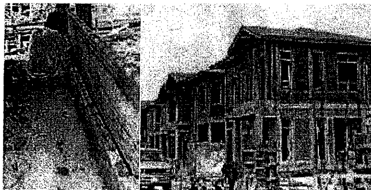
รูปที่ 2.30 แสดงการก่ออิฐมอญ 2 ชั้น เป็นผนังอาคาร
