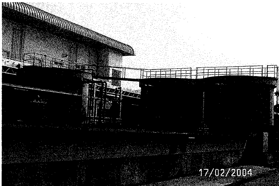
รูปที่ 11 แสดงถังน้ำดื่มที่ใช้ในการปรับสภาพน้ำเพื่อเตรียมน้ำใช้ในโรงงาน
