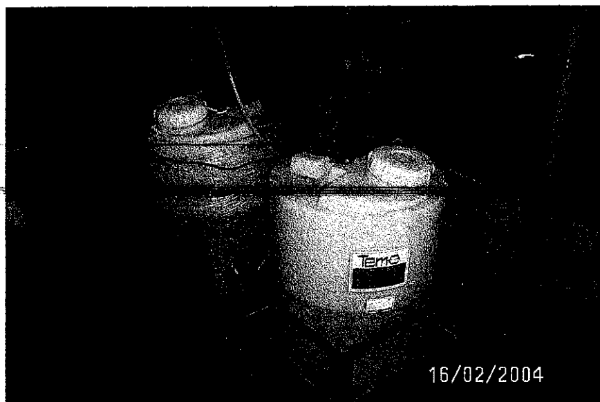
รูปที่ 3 แสดงเครื่องฉีดน้ำยา 552 ซึ่งเป็นน้ำยาป้องกันออกซิเจน เพราะออกซิเจนนี้จะไปทำการกัดกร่อนหม้อไอน้ำได้
