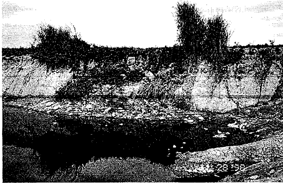
รูปที่ 47 บ่อระบายน้ำทิ้งจากหลุมฝังขยะ
