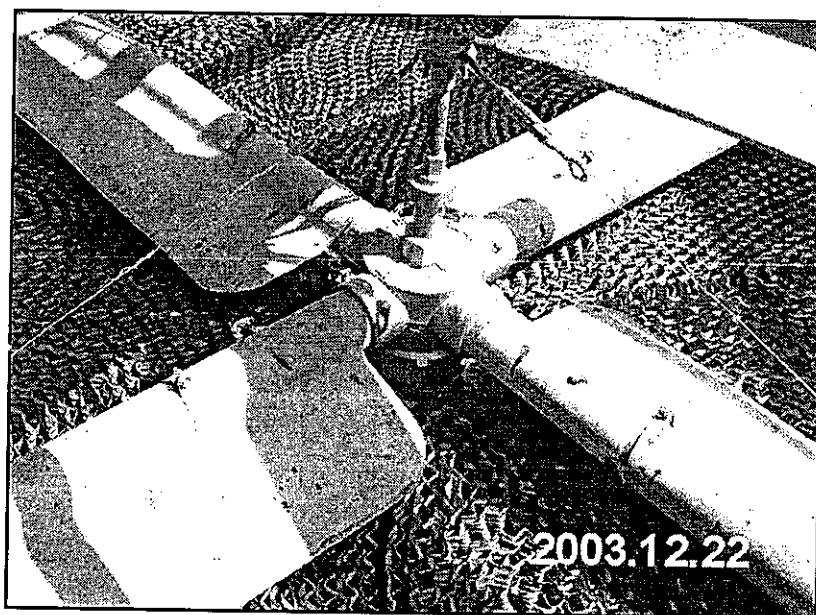
ข. ภาพหลังการซ่อมบำรุงของท่อกระจายน้ำ และหัวกระจายน้ำ
