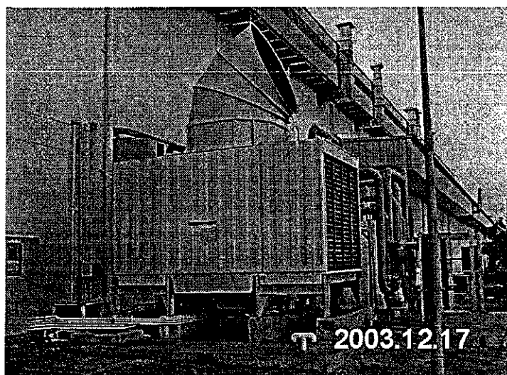
รูปที่ 3.22 ตัวอย่างการติดตั้งปล่องข้องอของ Induced Draft Cross Flow
