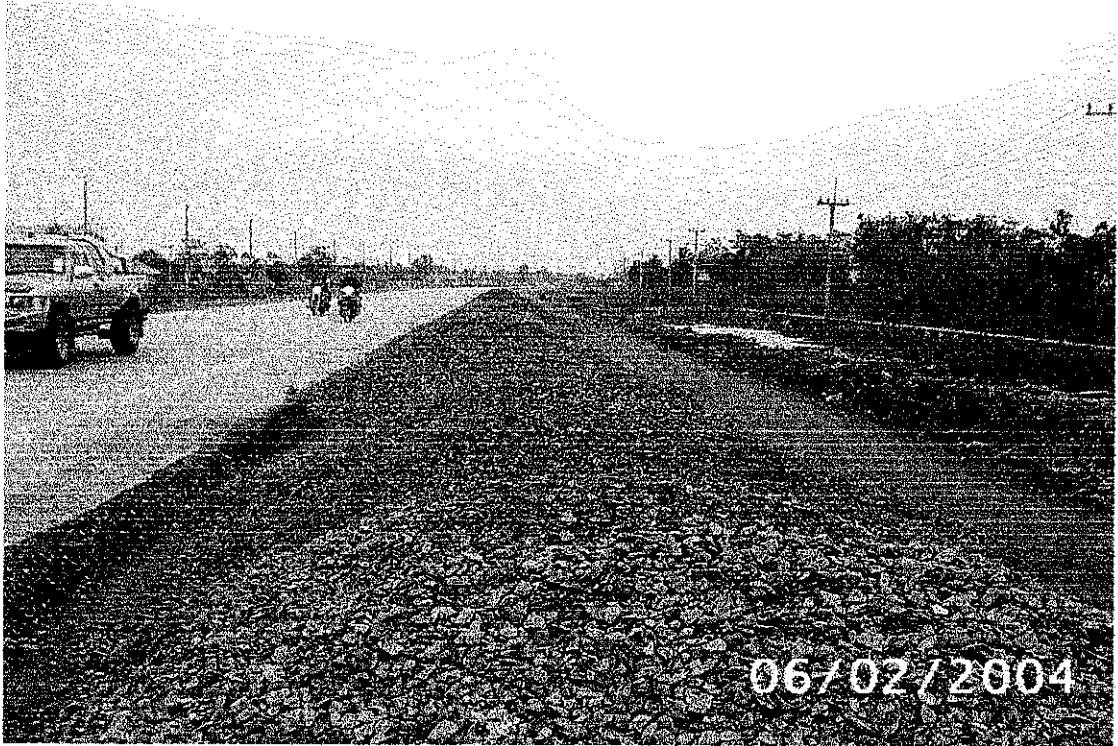
รูปที่ 5 ลงหินคลุกรองพื้นทาง
