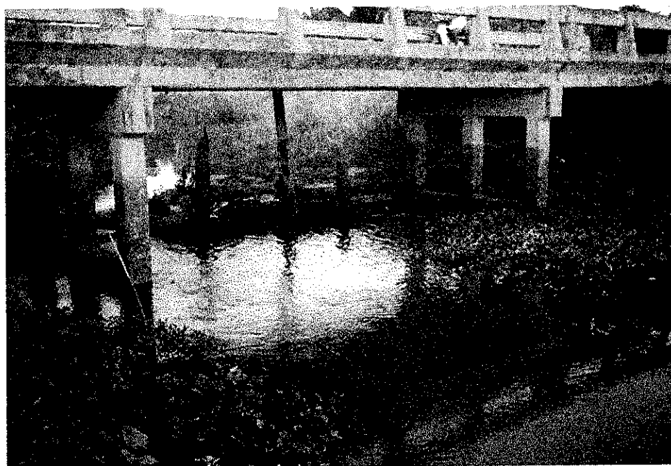
รูปที่ 3.13 บริเวณดักปลาของชาวบ้าน ทำให้การไหลของน้ำไม่สะดวก
