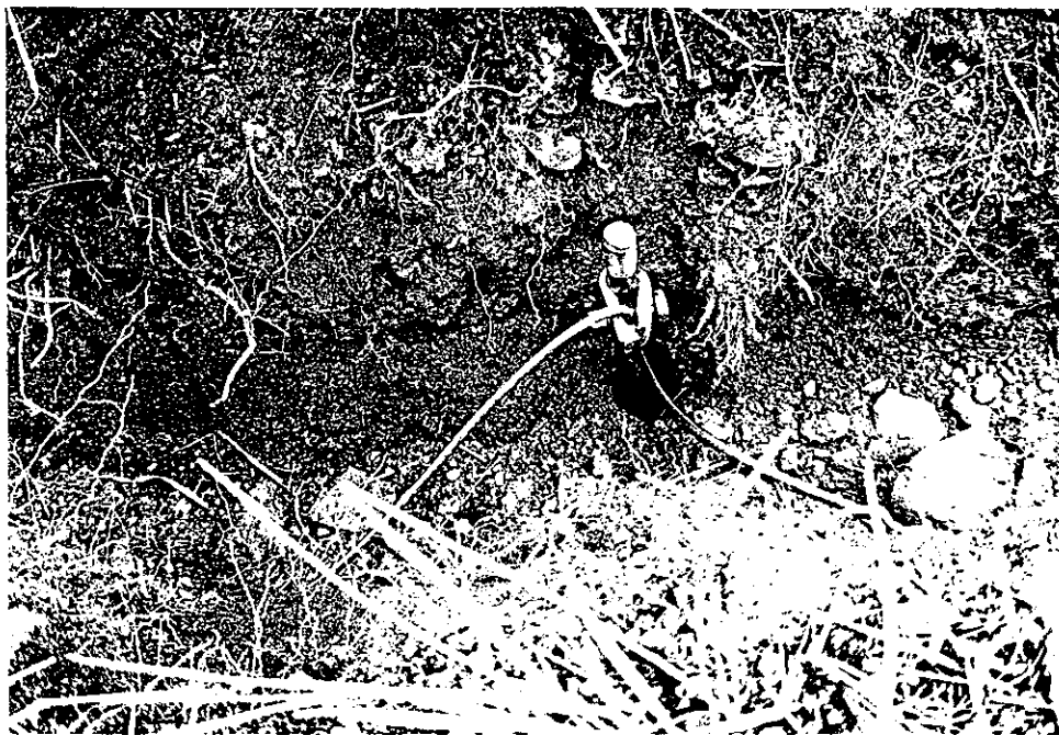
รูปที่ 2.14 ต่อกราวด์ด้วยตัวหนีบ(Clamp)ในกรณีไม่ใช้วิธีเชื่อม(Adapter)
