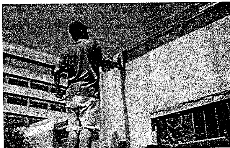
รูปที่ 3.14 แสดงการตักแต่งคานเหล็ก
