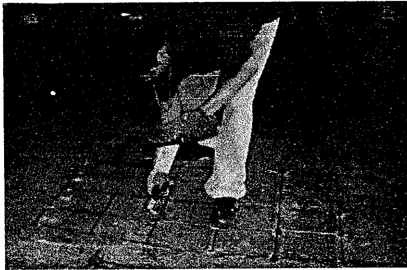
รูปที่ 3.3 แสดงการเชื่อมเหล็กด้วยไฟฟ้า
