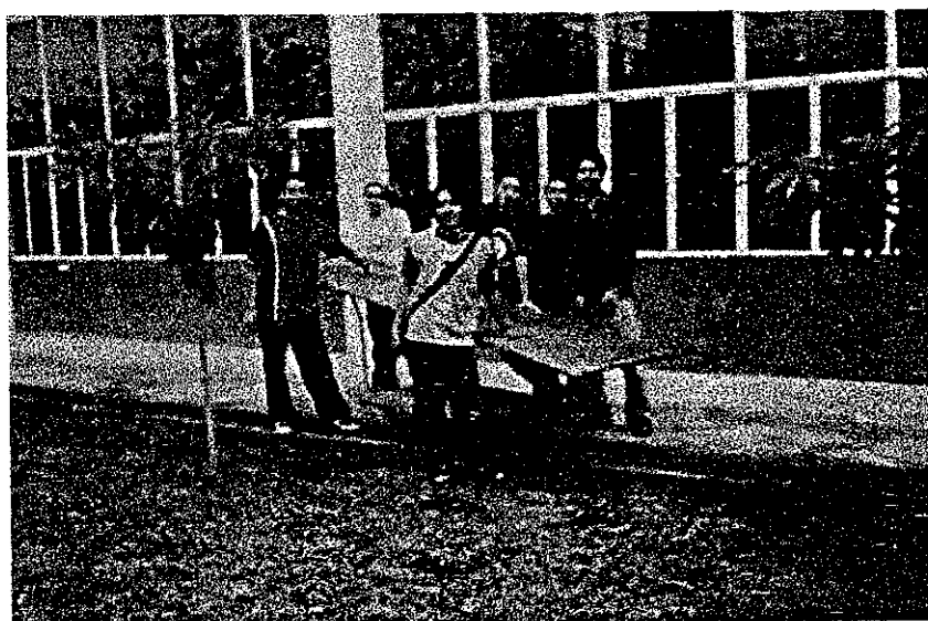
รูปที่ 3.11 แสดงการเคลื่อนย้ายแผ่นผนัง
