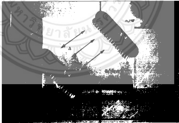
รูปที่ 1.13 ทำความสะอาดแผ่นค้ำจับฝุ่นและแท่งโลหะแกนกลาง
