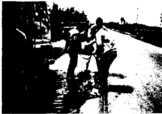
รูปที่ 2.29 กรณีรอยแตกมีความกว้างมากกว่าหรือเท่ากับ 5 มิลลิเมตรให้ใช้แอสฟัลต์ผสมวัสดุละเอียด อุดจนเต็มรอยแตก ที่มา: กรมทางหลวงชนบท (2555)
