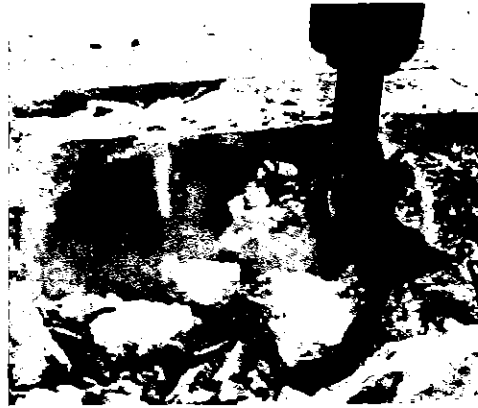
รูปที่ 2.54 รูปการชุดรื้อพื้นทางคอนกรีตเดิมออก ที่มา: กรมทางหลวงชนบท (2555)
