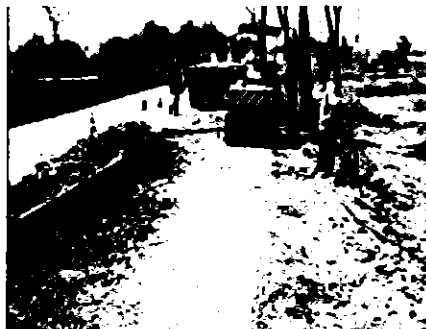
รูปที่ 2.47 การบดทับกันหลุมให้แน่นเรียบสม่ำเสมอ ที่มา: กรมทางหลวงชนบท (2555)
