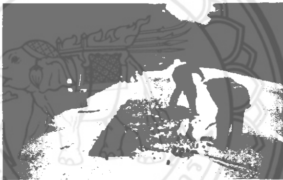
รูปที่ 2.36 การโรยหินย่อยหรือกรวดย่อยปิดทับหน้าแอสฟัลต์
