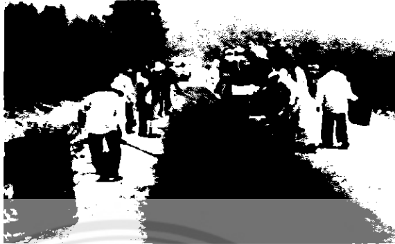
รูปที่ 2.50 ปูวัสดุผสมเสร็จพร้อมเกลี่ยปรับแต่งระดับให้เรียบร้อย ที่มา: กรมทางหลวงชนบท (2555)
