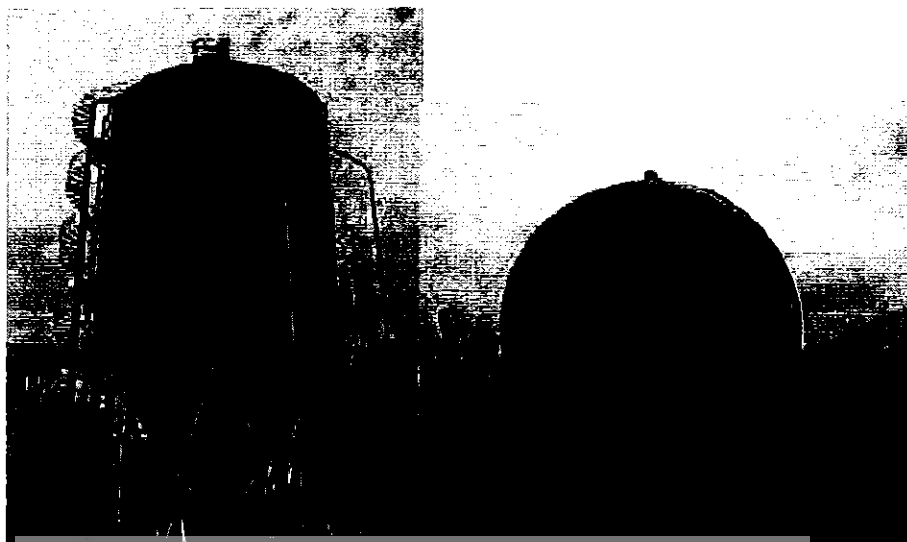
รูปที่ 2.5 แสดงถังย่อยสลายแบบไม่ใช้ออกซิเจน และถังเก็บก๊าซชีวภาพ โครงการผลิตปุ๋ยอินทรีย์ และพลังงานจังหวัดระยอง เทศบาลนครระยอง
