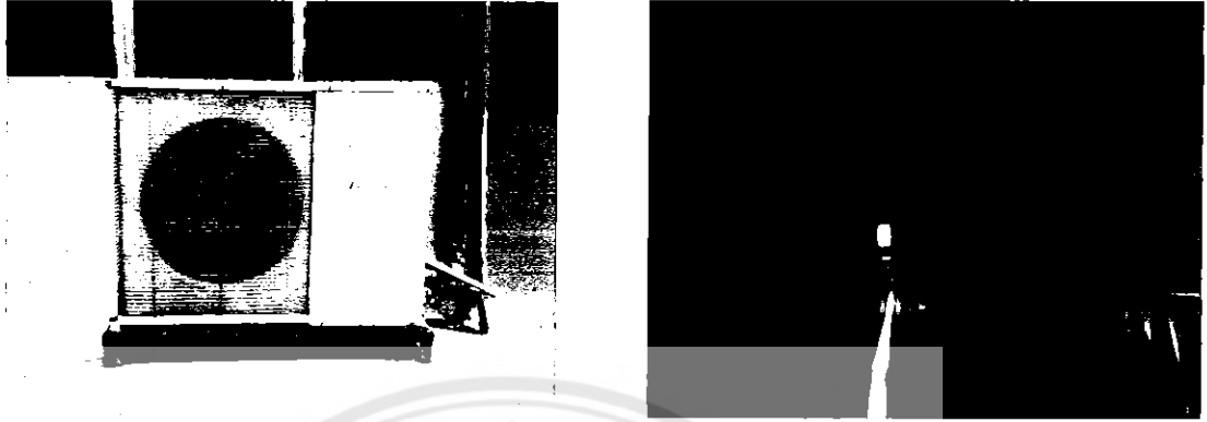
รูปที่ 4.2 แสดงตัวอย่าง Air Split Type
