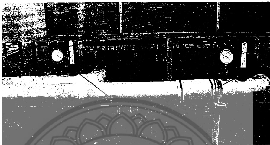
รูปที่ 2.19 คอยล์เย็น (Evaporator)
