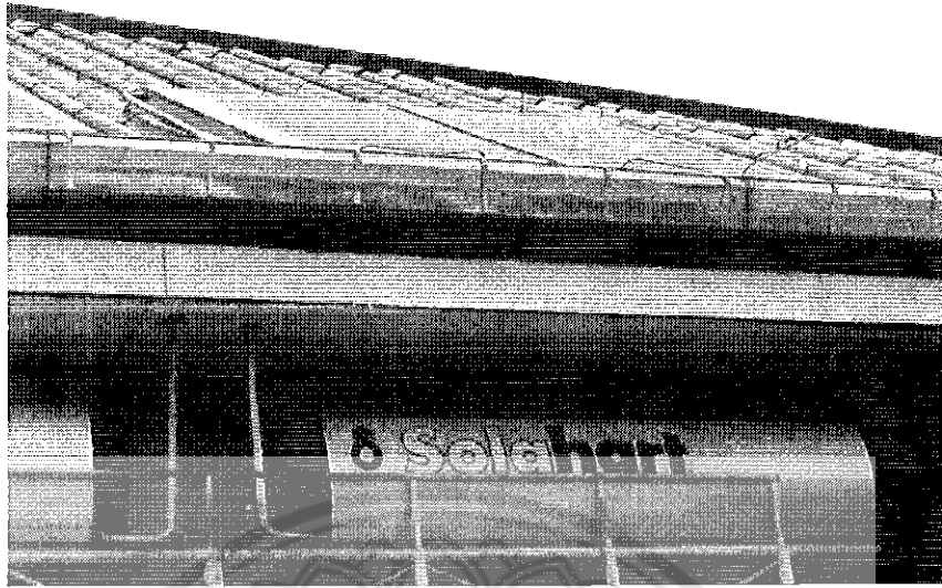
รูปที่ 1.4 เครื่องทำน้ำร้อนพลังงานแสงอาทิตย์ที่ใช้พลังงานเสริมจากฮีตเตอร์ไฟฟ้า [ที่มา: โรงพยาบาลพุทธชินราช]
