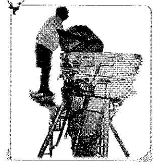
นำแบบมาประกบกันจากนั้น จึงเทปูนด้านในของแบบ
