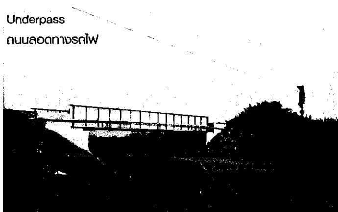
รูปที่ 4.19 ทางผ่านแบบ Underpass
