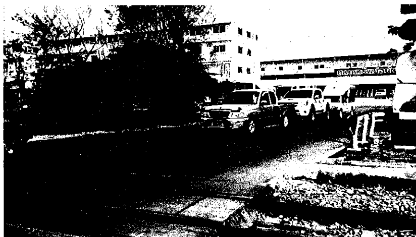
รูปที่ 4.30 จุดตัดทางรถไฟจุดที่ 6 ถนนมาลาเปียง
